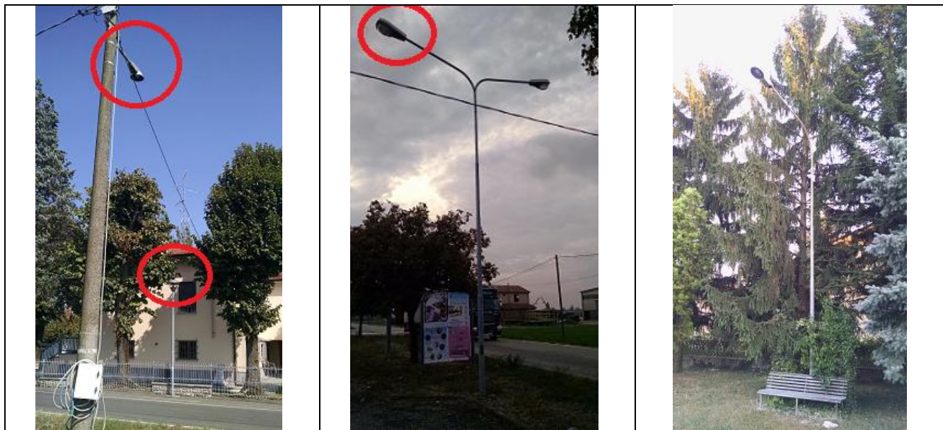
Apparecchi sovradimensionati o impropriamente collocati:
